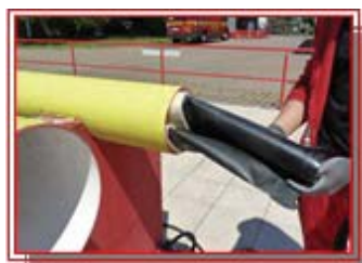
Помещение в канал
