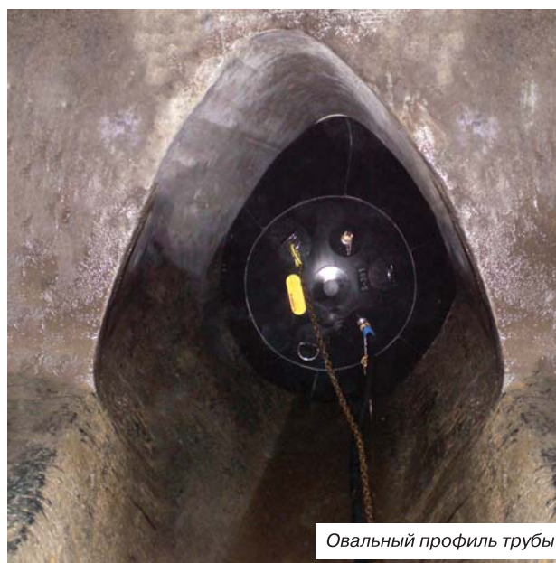
Установка ПЗУ в разные профили трубы
