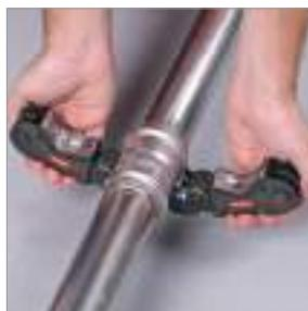
Закрывание пресс-клещей для труб больших диаметров
