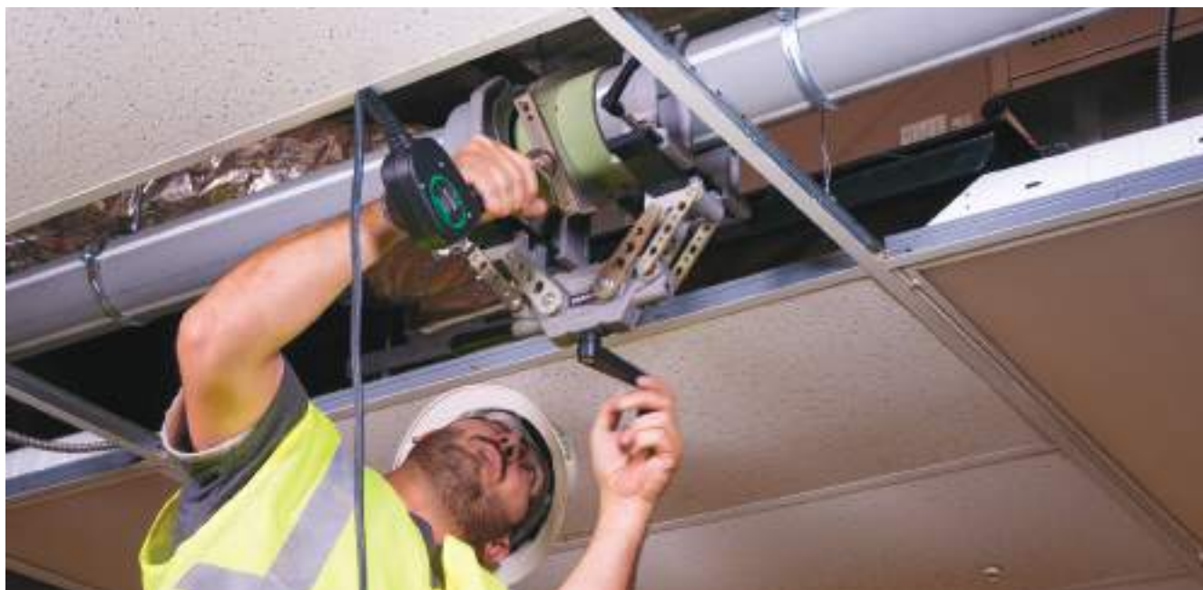
Spider™ 125 — универсальный зажим для работ в узких местах
