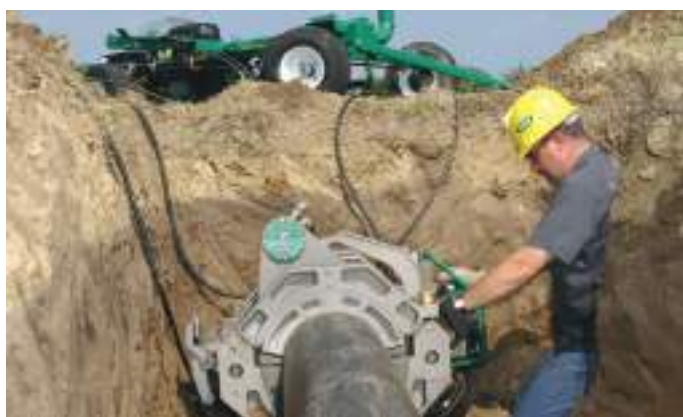
Rolling 618™ со снятым центратором, сварка трубы в траншее
