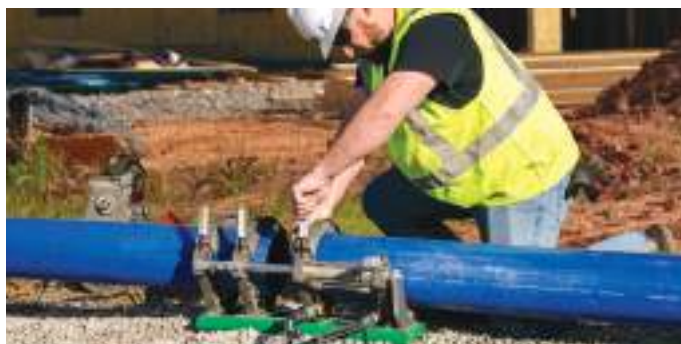
Сварщик помещает трубу в Acrobat™ 180
