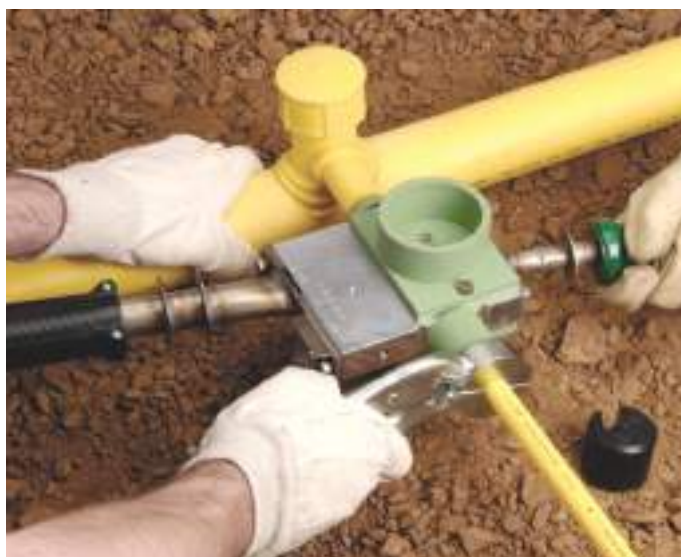
Socket fusion в работе
