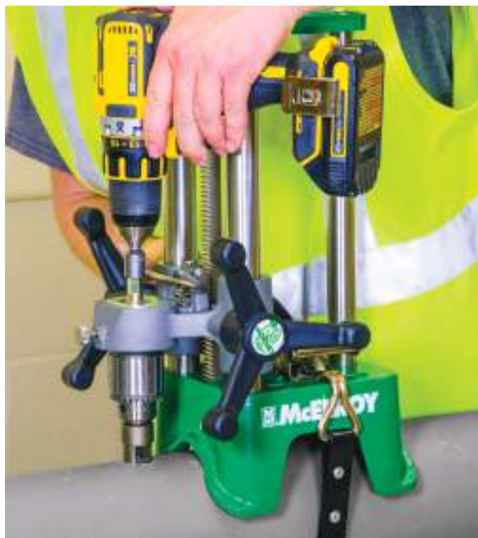
Сварщик сверлит отверстие в главной трубе для приварки седловых отводов Hornet™
