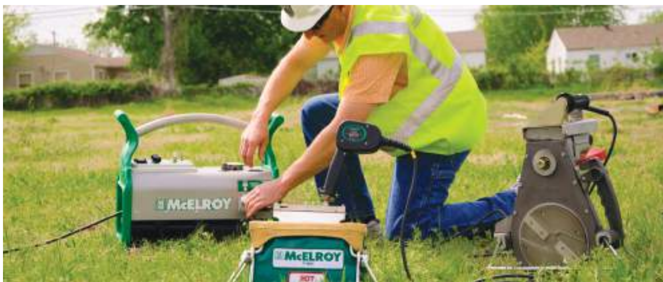
Сварщик подключает нагревательный элемент и торцеватель к Acrobat™ HPU
