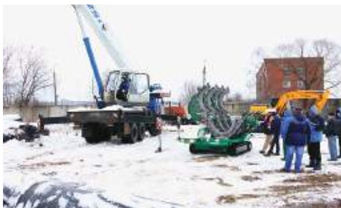
TracStar 1200. Монтаж полиэтиленовых труб водоснабжения диаметром 800 мм, г. Жуковский, 2013 г
