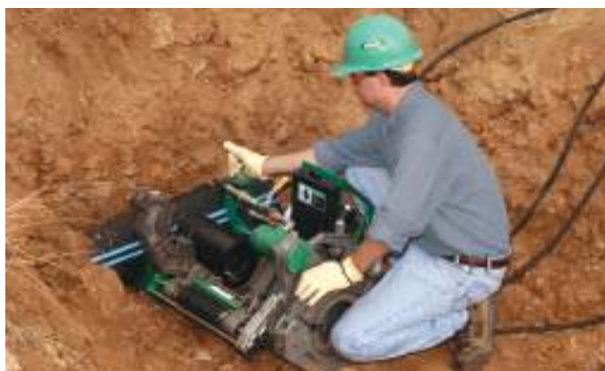
Pit Bull® 28 CU, завершающий этап сварки трубы в траншее
