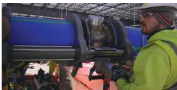
Сварщик подключает торцеватель к центратору Acrobat™ 355
