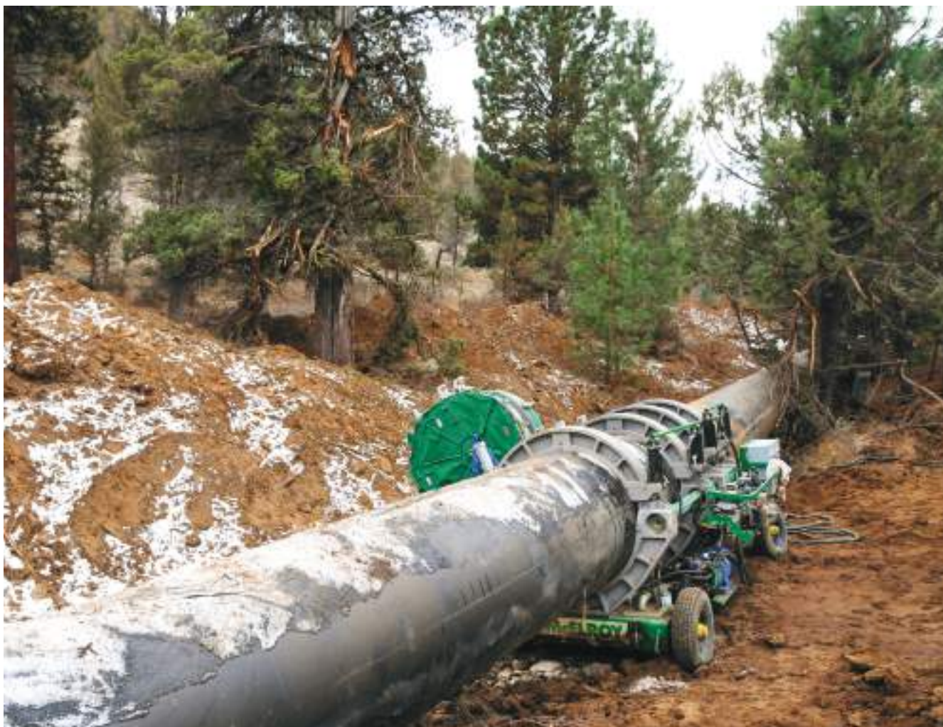
МегаМс 1236, центрирование 4 основными зажимами, Систер, Орегон
