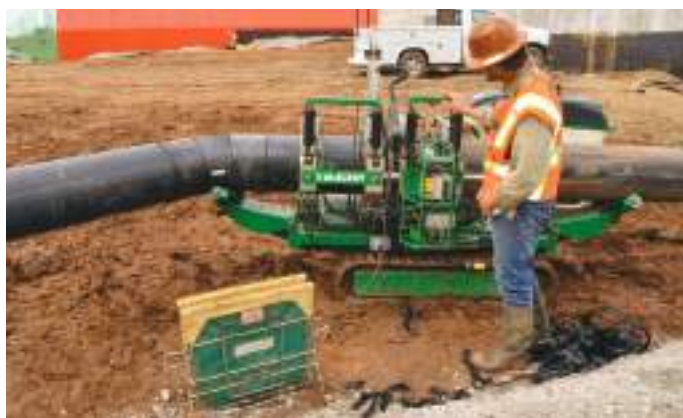
TracStar 618, сварка труб, Талса, Оклахома
