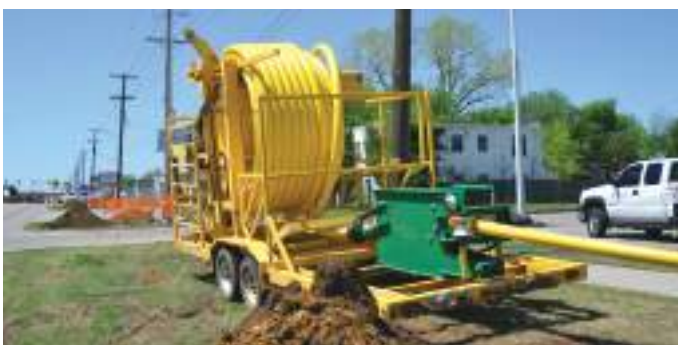
LineTamer® в работе, прокладка газовой трубы, Талса, Оклахома
