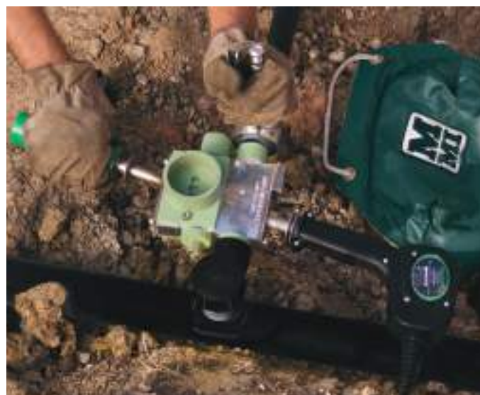
Socket fusion в работе
