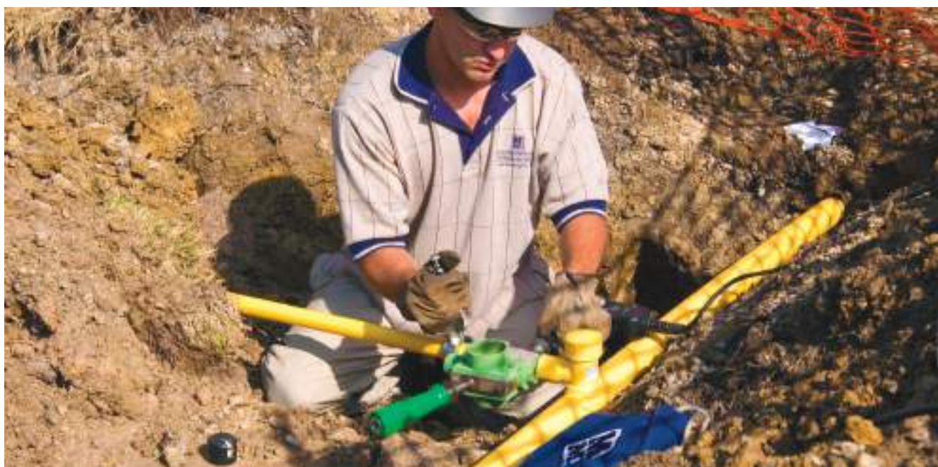
Socket fusion в работе
