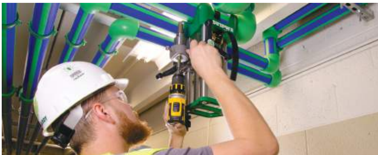
Сварщик готовится просверлить отверстие для Hornet™
