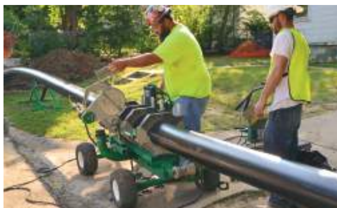
Rolling 28™, сварка труб на улице Независимости, Талса, штат Оклахома
