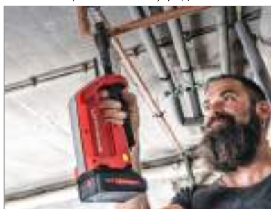
Twin Turbo при монтаже внутридомовых сетей
