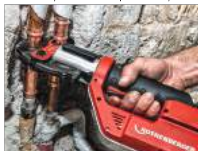
Twin Turbo при выполнении ремонтных работ
