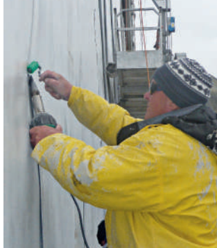
TRIAC ST при сварке гидроизолирующего покрытия
