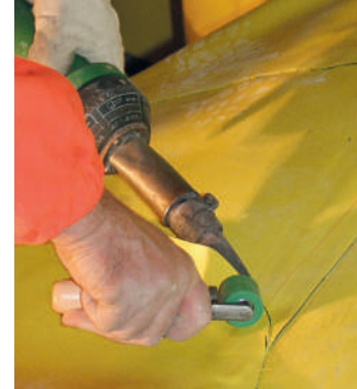
Прикаточный ролик — незаменимая принадлежность при проведении работ в туннелях
