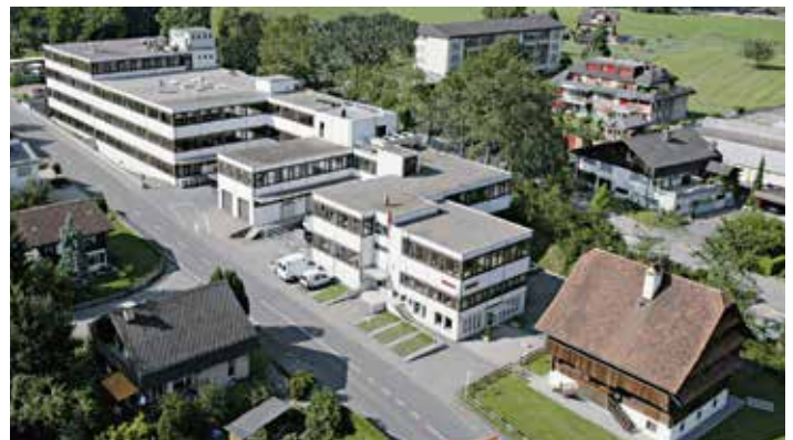
Leister Technologies AG, производственное здание, Кегисвиль, Швейцария
