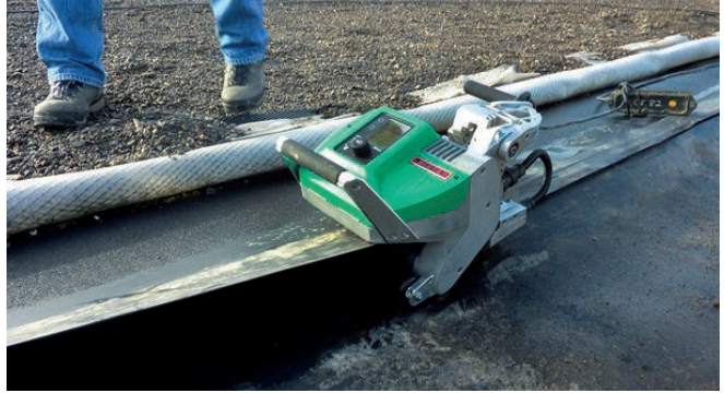
GEOSTAR без проблем сварил шов длиной около 240 метров за один проход во время полевых испытаний (Южная Африка)
