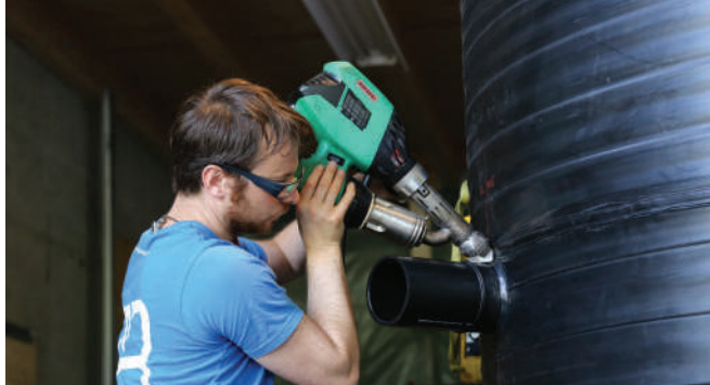
Удобный WELDPLAST S2 в работе
