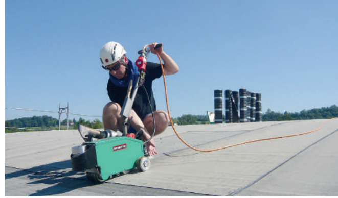
BITUMAT B2 безупречно сваривает эластомерный битум
