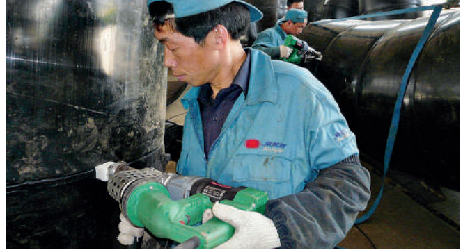
Экструдер FUSION 2 при сварке резервуара
