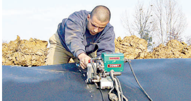
... на обустройстве полигона
