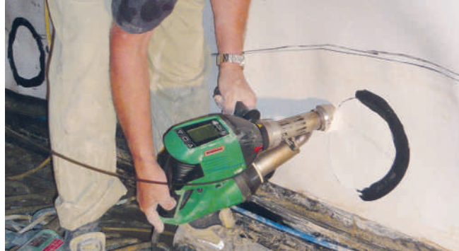
Эргономичный WELDPLAST S2 при сварке заплатки в туннельном строительстве
