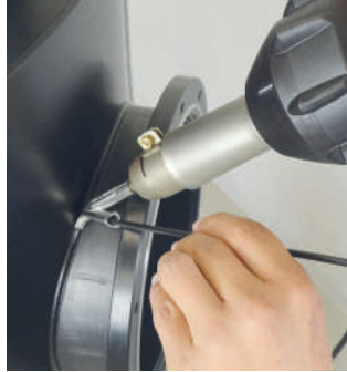
TRIAC AT: сварка трубы с помощью насадки быстрой сварки
