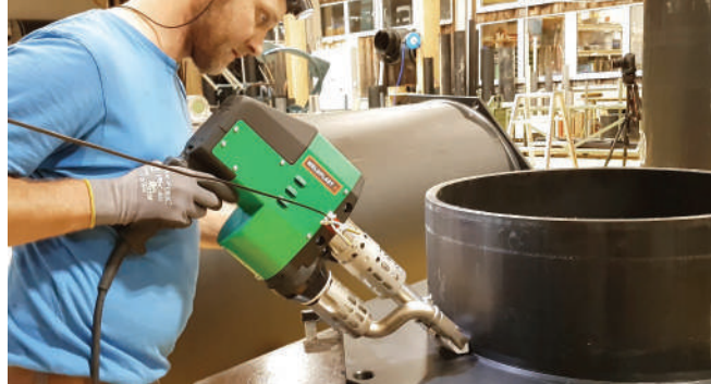
Мощный WELDPLAST S4 в работе
