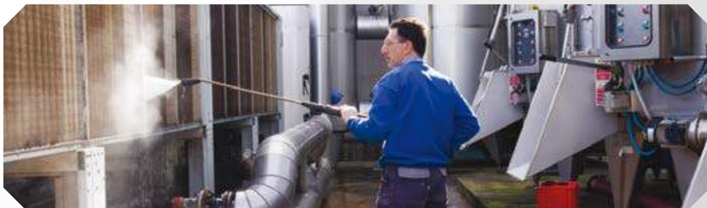
Мойка производственных помещений
