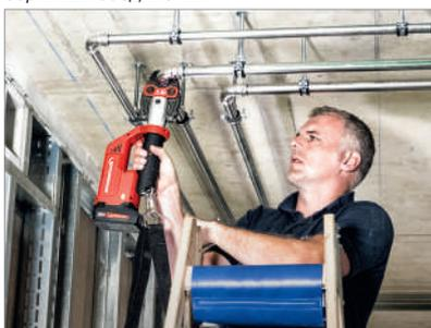
Twin Turbo при монтаже внутридомовых сетей
