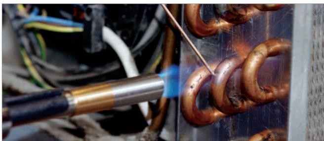
Высокая температура пламени благодаря циклонному закручиванию потока газа
