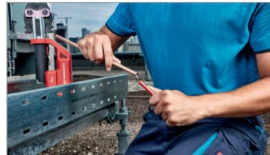
4. Вращательными движениями зачистите конец трубы, чтобы избежать царапин, идущих параллельно оси трубы
