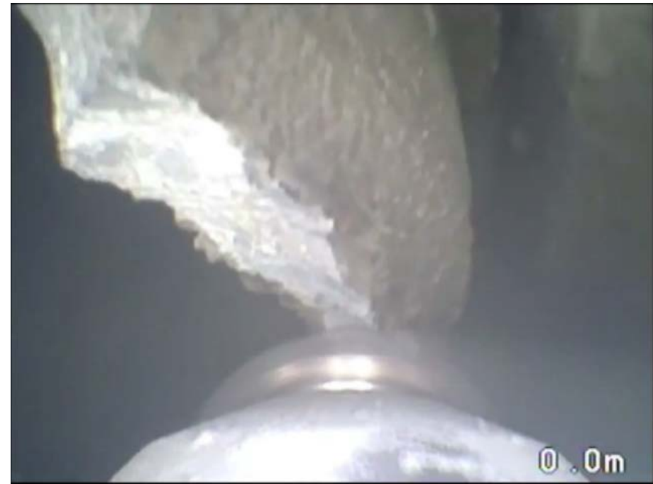
Работа с бетонной трубой
