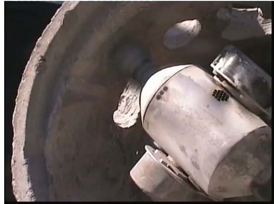
Работа с бетонной трубой
