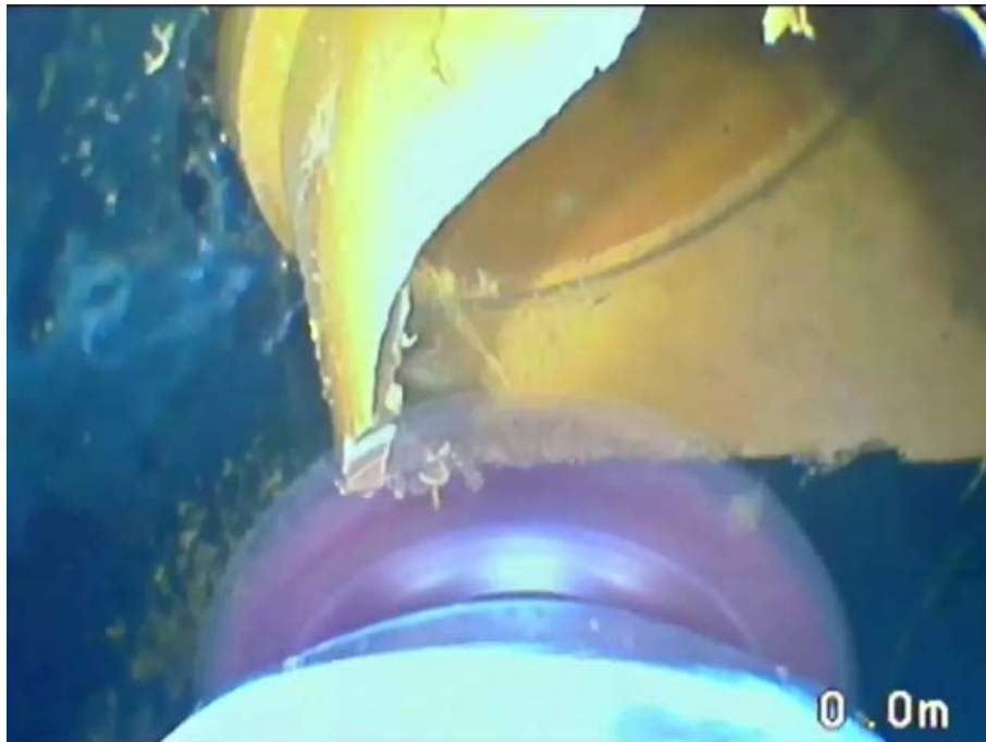
Работа с пластиковой трубой
